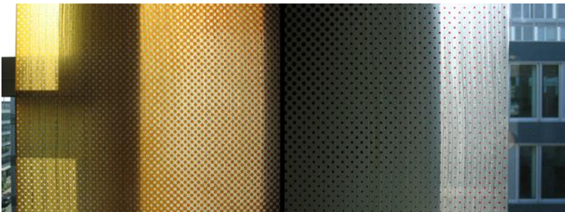
Abbildungen oben: Zwei Details der gelben und purpurnen Glasmalerei mit dem Sandstrahlton und einem Ausblick links und rechts neben der Glasmalerei. Auch hier sind die dunklen Zonen durch Beschattung bewirkt.
